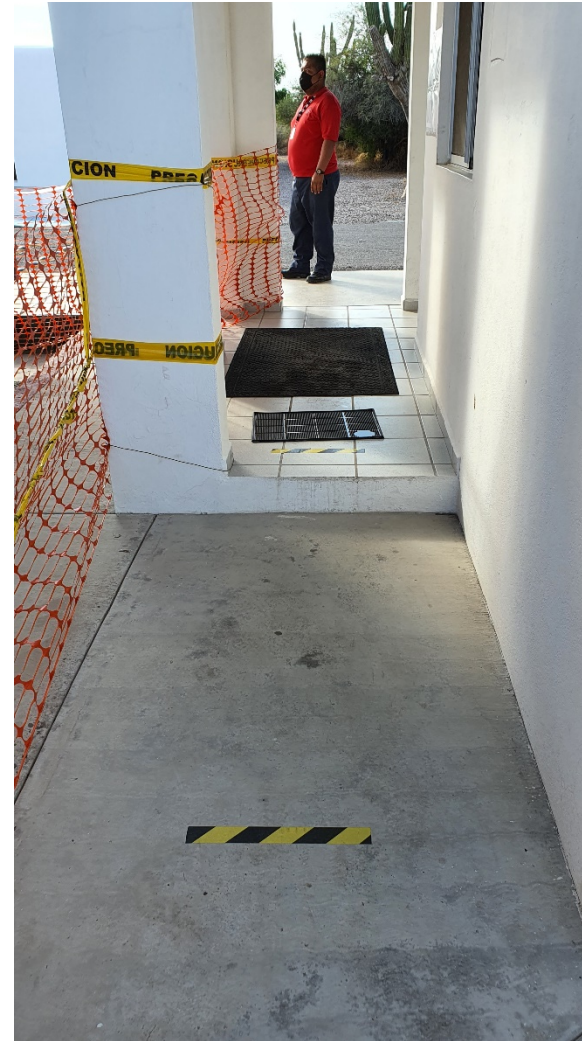
Imagen 17. Filtro sanitario Fuente: Propia.
