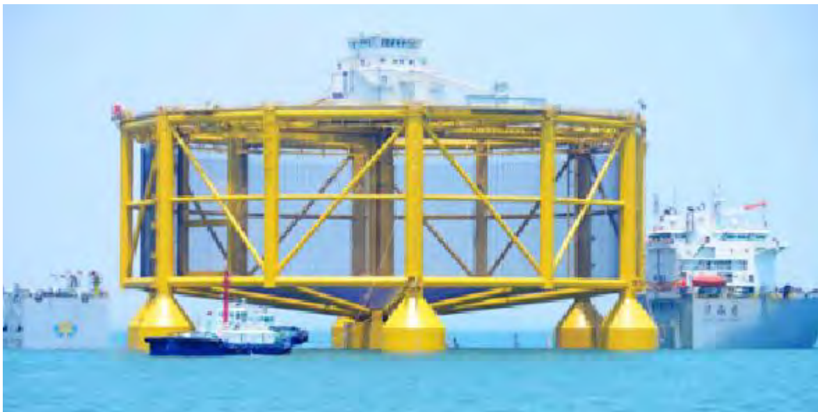
Figura 4. Jaula de cultivo inteligente de salmón a gran escala para aguas profundas. Dimensiones: altura de 71.5 m, diámetro de 70 m, volumen de 90,000 m 3 . Tomada de infosalmon.cl
